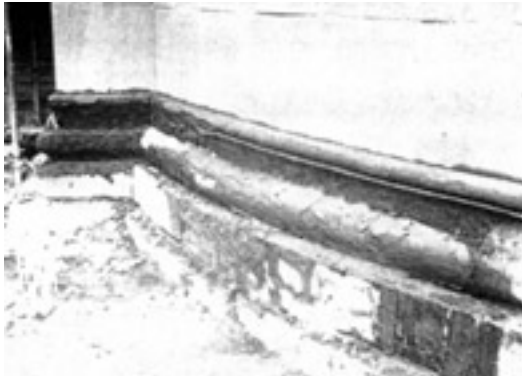
Antragung von Steinersatzmasse an den Sockelprofilen der Ostapsis, 1975
