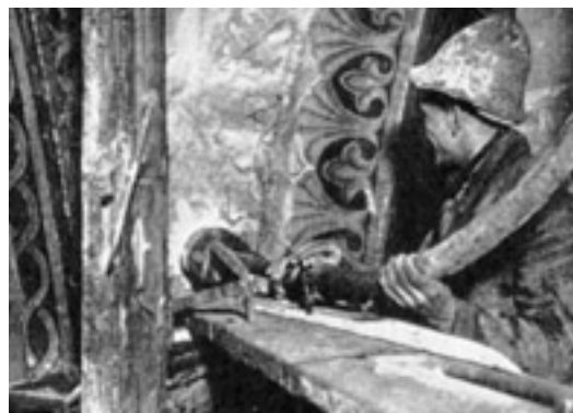
Zementmilcheinpressungen am Westturm
